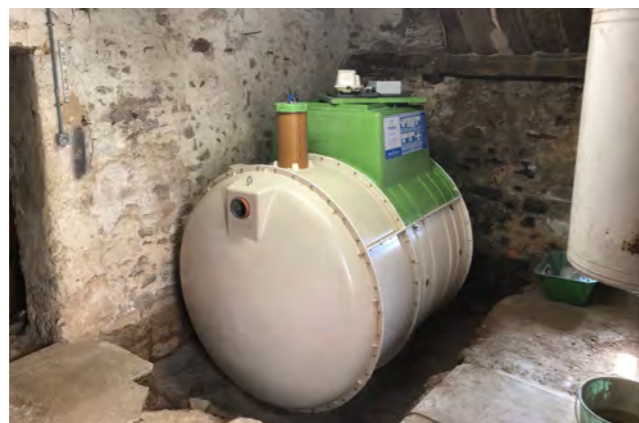
Exemple de pose assimilée enterrée
