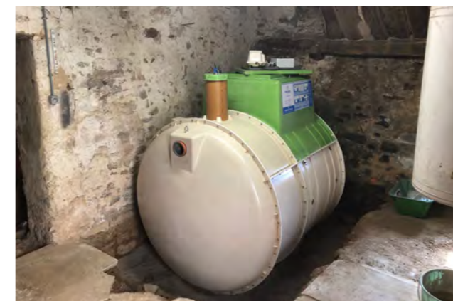
Exemple de pose assimilée enterrée
